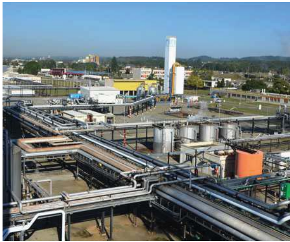
La Sobegi, qui génère 100 millions d'euros de chiffre d'affaires, compte une trentaine de clients et fournit les « utilités » (eau, vapeur, etc.) aux industriels du bassin de Lacq. © SÉNÉ
