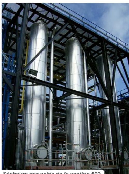
Sécheurs gaz acide de la section 500
