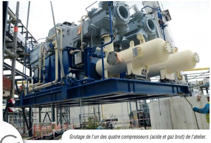
Grutage de l'un des quatre compresseurs (acide et gaz brut) de l'atelier.
