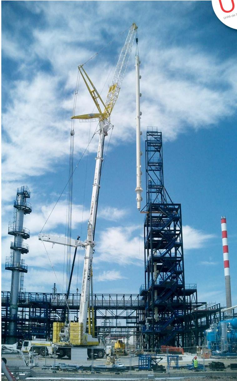
Deux étapes de la mise en place de la colonne de décarbonation C3610 de 40 m de hauteur supportée par une grue de 450t. Dans un souci d'optimisation des moyens de levage, les deux autres colonnes de désulfuration ont été installées dans le même temps.
