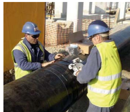
Réfection du revêtement réseau ER24 pour eau réfrigérée
